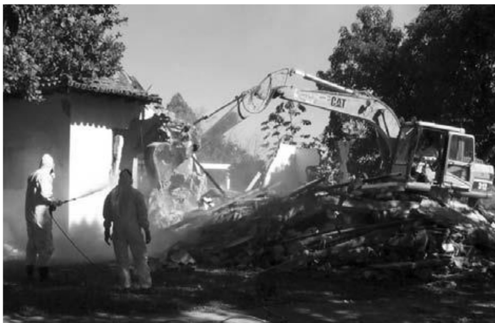
FIGURA 17 – DEMOLIÇÃO DAS CASAS PRÓXIMAS À ÁREA FOCO – DÉCADA DE 1990
